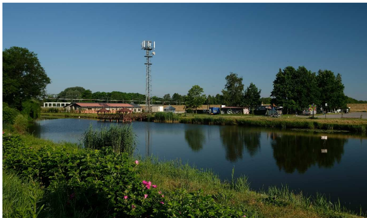
Stacja bazowa telefonii komórkowej w m. Baranów Sandomierski.
