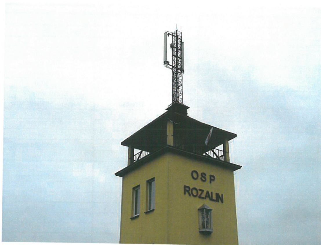
Fot. 1. BT_24426 Rozalin – widok obiektu
