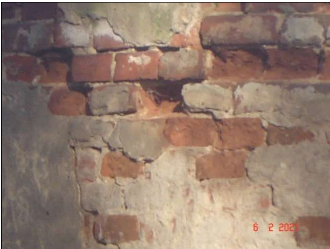
Fot. 6 Mur ogrodzeniowy – ubytki.
