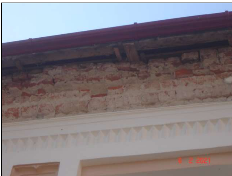
Fot. 1 Zniszczony gzyms zewnętrzny na elewacji północno-wschodniej - widok.
