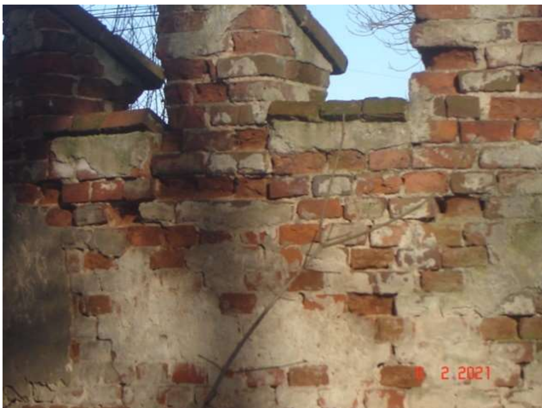
Fot. 4 Mur ogrodzeniowy – strona południowo-wschodnia – stan zachowania górnej części muru.
