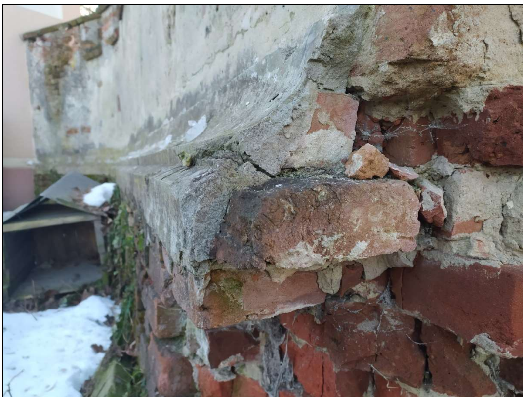
Fot. 7 Mur ogrodzeniowy – ubytki gzymsu przy podstawie.
