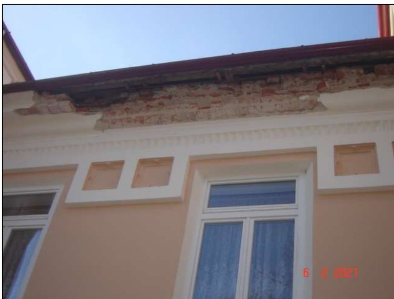
Fot. 2 Zniszczony gzyms zewnętrzny na elewacji północno-wschodniej - widok.
