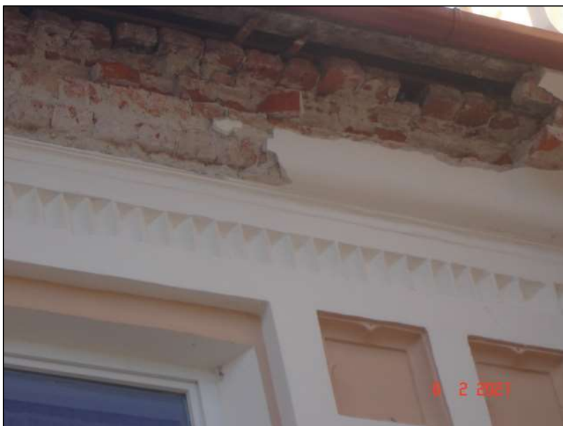
Fot. 3 Zniszczony gzyms zewnętrzny na elewacji północno-wschodniej - widok.
