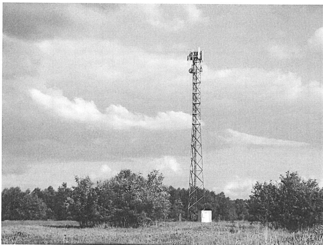
Fot. 1. BT_24179_WOLA BARANOWSKA – widok wieży antenowej
